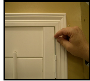
Insert hinge pin.
